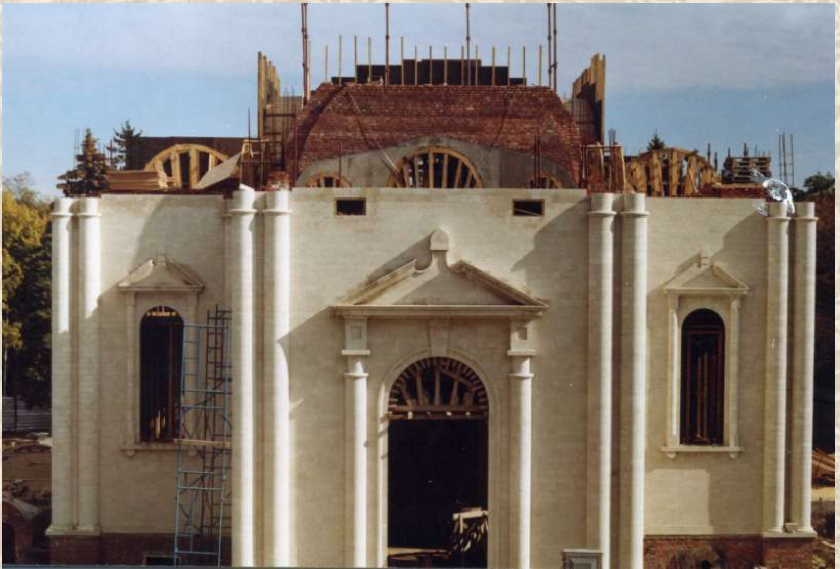
Строительство Казанского кафедрального собора в городе Ставрополе. 2006 год.
